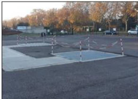
Visuel de caves têtes de puits équivalentes à celles mise en place sur le futur site de Rueil-Malmaison
