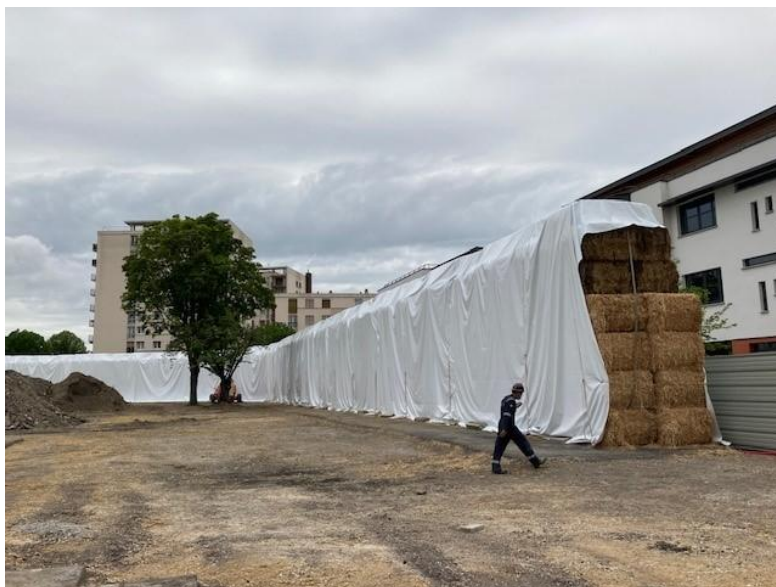
Visuel du mur acoustique périphérique (avant et après la pose de la bâche ignifugée)
